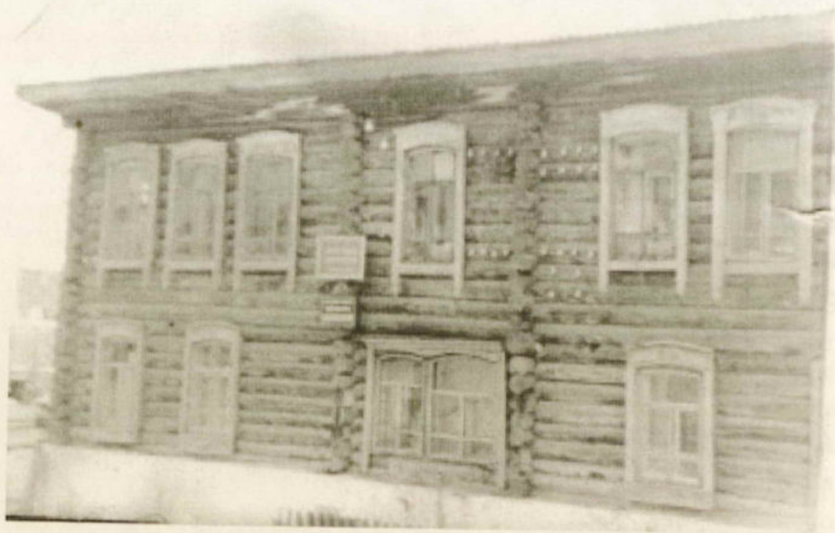
Здание, в котором размещался райгосархив в 1950–1979 годы. с. Колосовка, ул. Калинина
